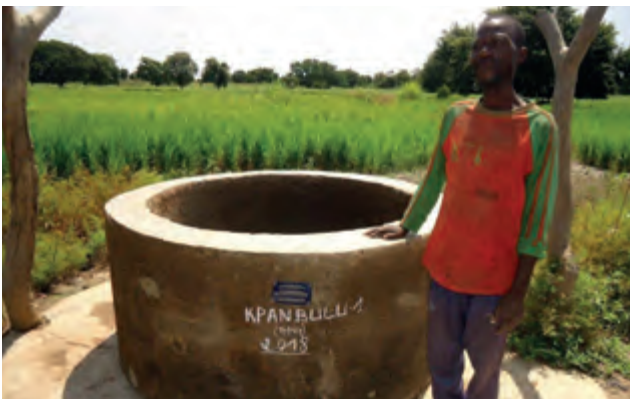
Der von der Dafinser Pfarrbevölkerung finanzierte Brunnen spendet kostbarstes Wasser für zahlreiche Familien sowie für die Bewässerung großer Gärten und Felder. Foto: Brunnenbauprojekt, Heribert Gut
