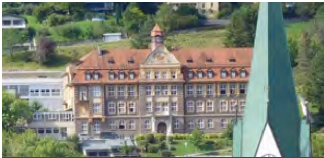
Institut St. Josef am Ardetzenberg: Private Mittelschule, Private Höhere Schule für wirtschaftliche Berufe (HLW), Private Bildungsanstalt für Elementarpädagogik
